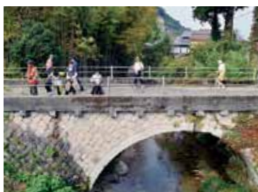
全国的にも非常に貴重な滝ヶ原のアーチ 石橋群の一つ、「丸竹橋」。
