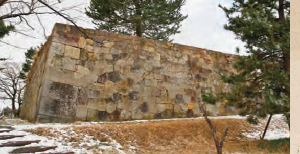
築城技術がピークに達した時代の石垣は、切込ハギと呼ばれる工法で金沢城にも使われている金沢産の戸室石が2割と地元小松産の鶴川石が8割の割合で隙間なく精緻に組み合わされている。また勾配がほぼ垂直になっているのも特徴。
