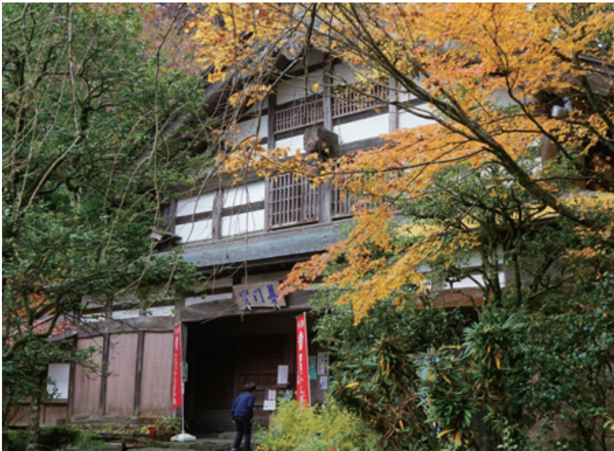
那谷寺に移築された春木家の家屋外観
